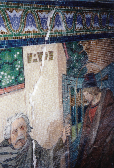
Reith bei Seefeld, Pfarrkirche: 1912/3, Mosaik im Chorraum (Diechtl & Co, Entwurf: Rudolf Margreiter) Detail, Riss. Restaurierung: 1989
